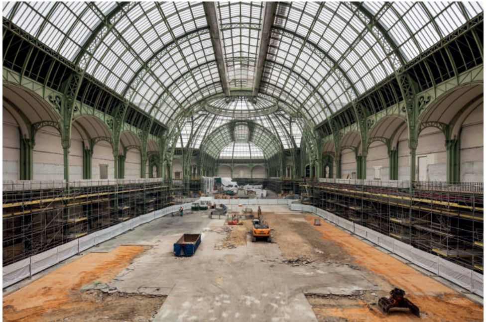
La Nef Nord du Grand Palais en travaux © Patrick Tourneboeuf chez Tendance Floue pour la Rmn-Grand Palais, 2022
