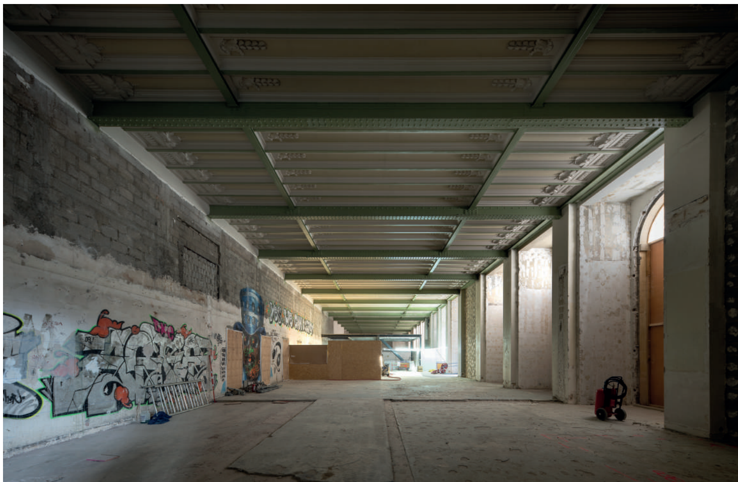
La Galerie Sud-Est, rez-de-chaussée, pendant les travaux © Patrick Tourneboeuf chez Tendance Floue pour la Rmn-Grand Palais, 2022
